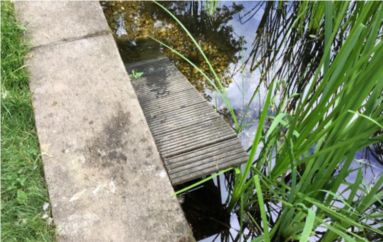
(b) Ententreppen müssen bis zum Grund des Gewässers angelegt werden um auch bei schwankenden Wasserständen den Tieren einen Ausstieg aus dem Wasserkörper zu ermöglichen.
